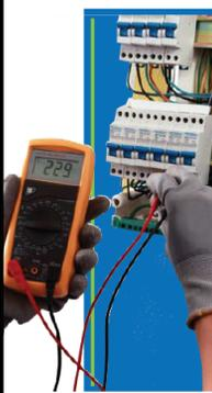
neutro del tablero principal esté realmente conectada con el neutro. Esa verificación será tanto para el TT como para el TN-S. De no colocar el neutro a tierra estaremos frente a un ECT IT que requiere dispositivos especiales de control y monitoreo (por ejemplo Monitores de aislamiento).
